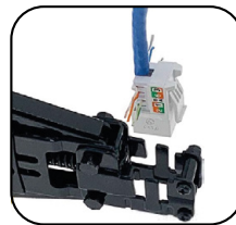
Insert the Keystone jack in the jack panel Inserta el conector en el panel correspondiente
